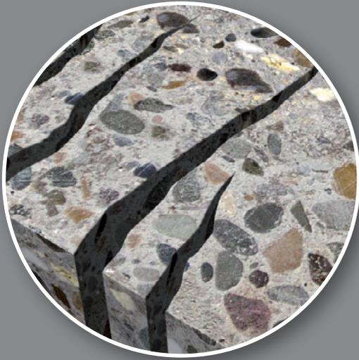
**Risse** können überall im Beton und zu jeder Zeit entstehen: Begünstigende Faktoren dafür sind Belastungen wie **Eigen-gewicht, Verkehrs- oder Windlasten**, Schwinden und Kriechen des Betons. Oder andere äußere Einflüsse wie Erdbeben oder Erschütterungen, die Spannungen, Verformungen und damit auch Rissbildung zur Folge haben. Die zahlreichen Risse sind mit bloßem Auge kaum sichtbar (i. d. R. maximal 0,4 mm breit).
